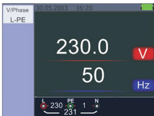
Fig. 5.2.7.2 Schermo durante la misura della tensione e della frequenza.
