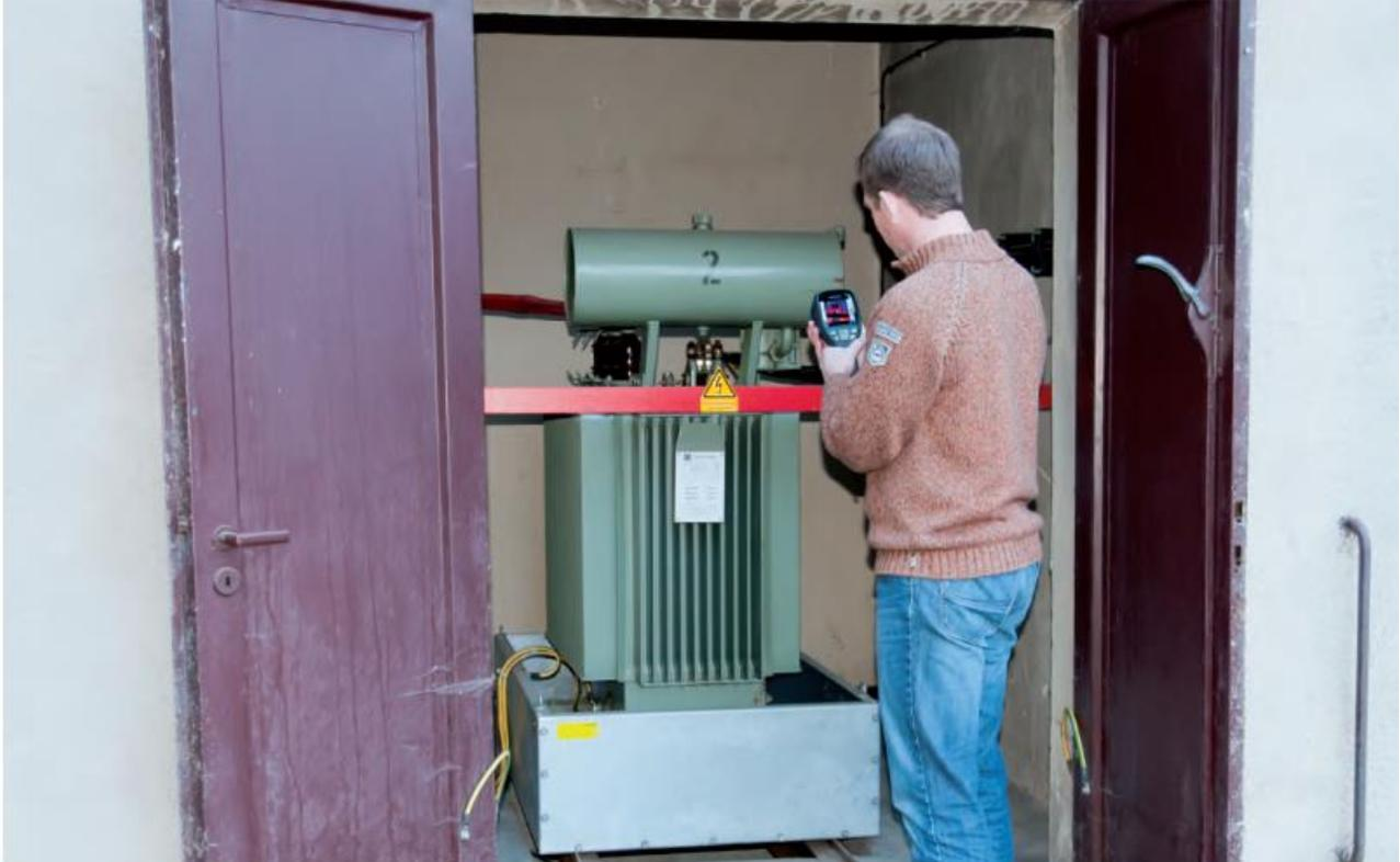
Câmera infravermelha na inspeção de um quadro de distribuição de alta tensão
