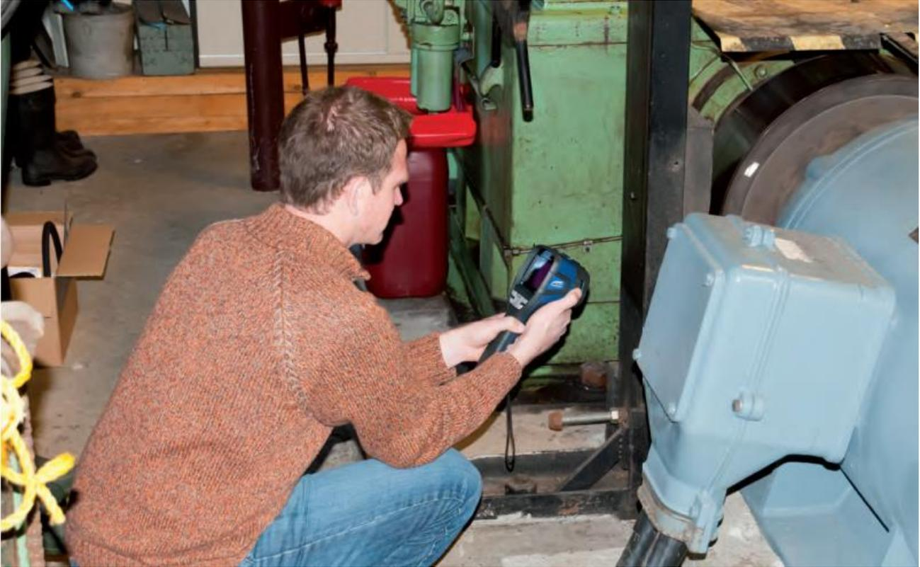
Manutenção de geradores em uma usina hidrelétrica usando um termômetro infravermelho ou uma câmera infravermelha.
