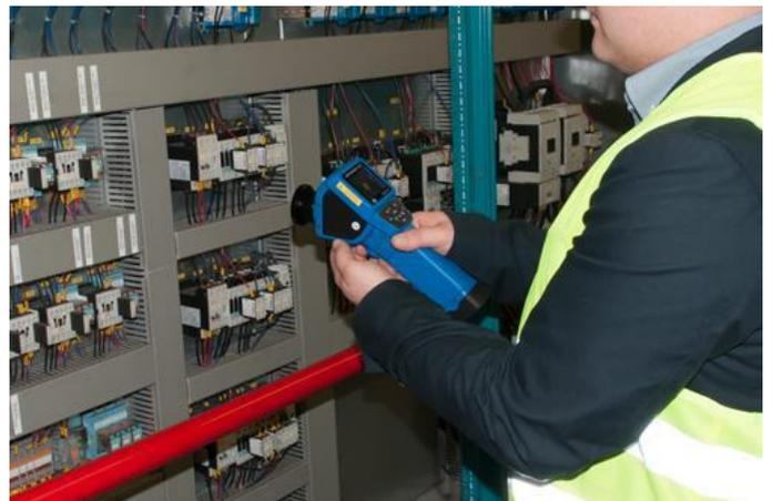
Deve-se prestar atenção ao ambiente em que o objeto de medição é operado. Um indicador de um problema existente é uma grande diferença visível entre a temperatura ambiente e a temperatura do dispositivo, da saída do cabo, do conduíte etc.
