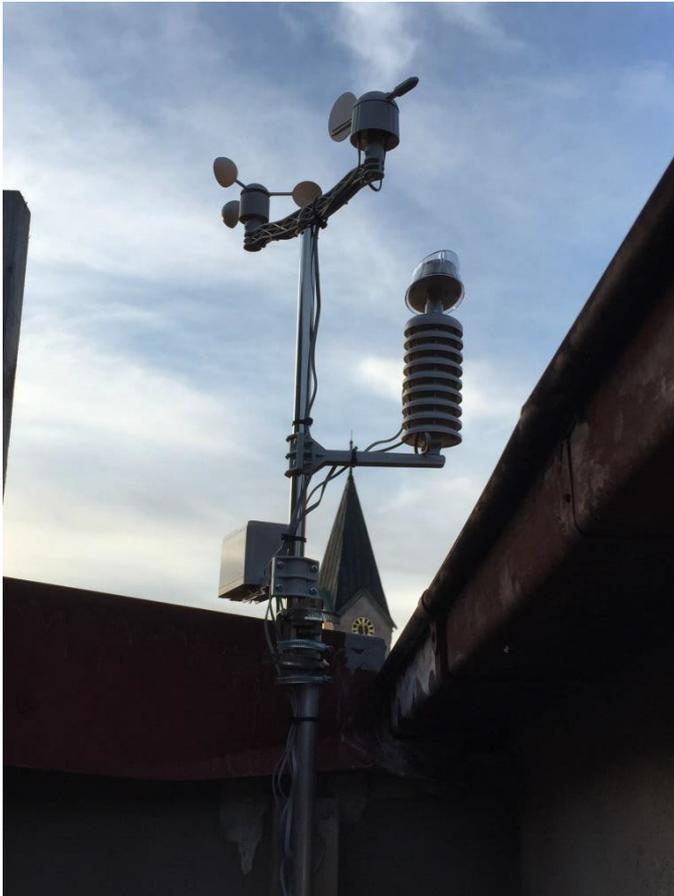
Dans mon cas, j'ai dû monter une poutre sur le mûr pour détourner le sortant sur le toit, et pouvoir installer la station. J'ai monté en plus sur la poutre un tuyau qui m'a permis d'atteindre la hauteur souhaitée. Vous pouvez trouver ces matériaux dans une quincaillerie. Le prix supplémentaire est d'environ 20 €.
