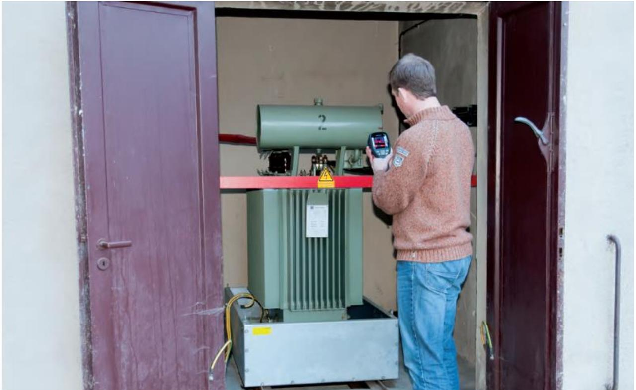
**Caméra infrarouge dans l'inspection d'un panneau à haute tension**
