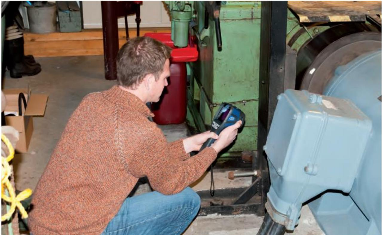
**Maintenance de générateurs dans une centrale hydroélectrique avec un thermomètre infrarouge ou une caméra infrarouge.**
