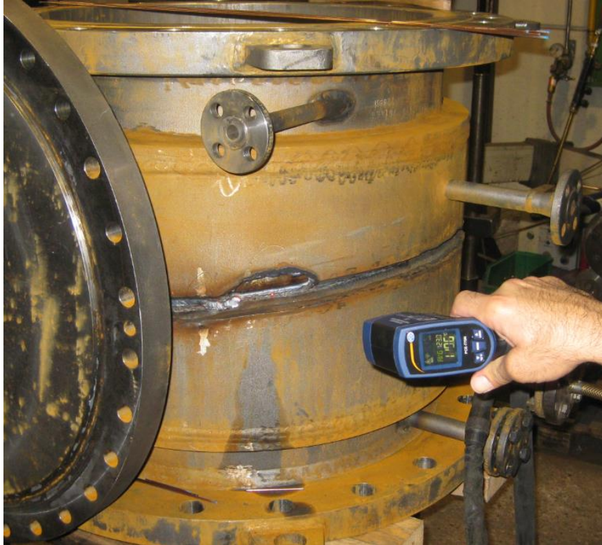
Comprobación de la temperatura de soldadura durante una reparación
