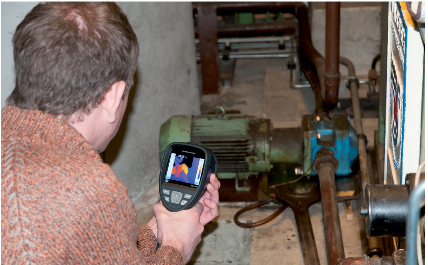
Inspektion von Motoren
