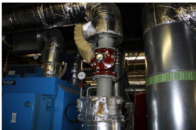
Heizzentrale der Schule mit defekter Dämmung
