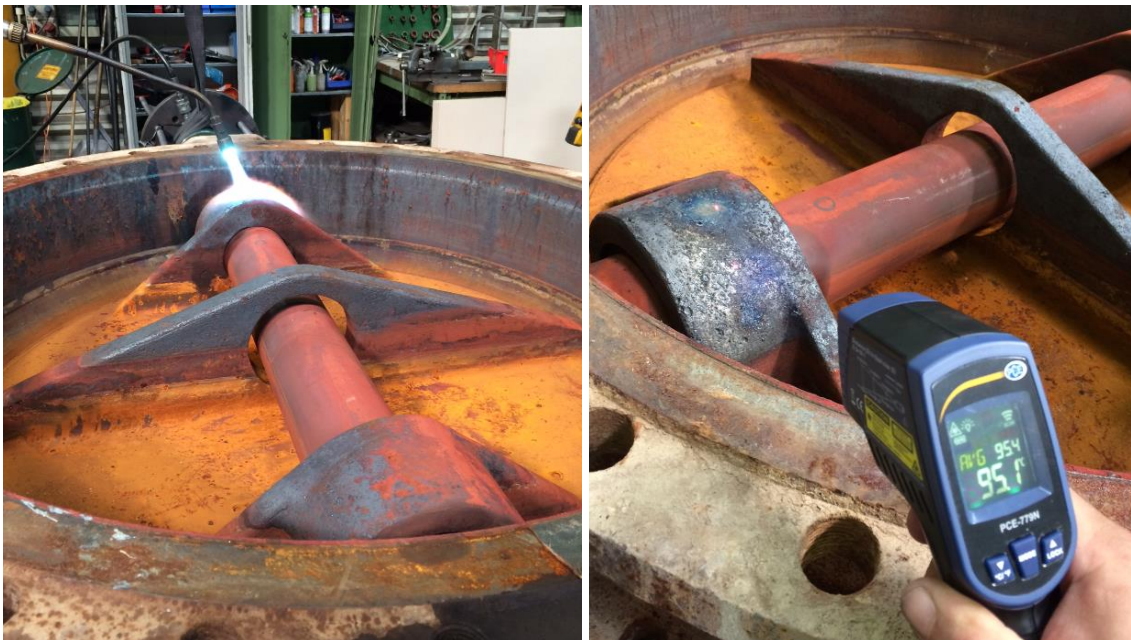
Erwärmung von den Disk-Naben und Kontrolle der Temperatur am Schaft vor dem Herausdrücken.
