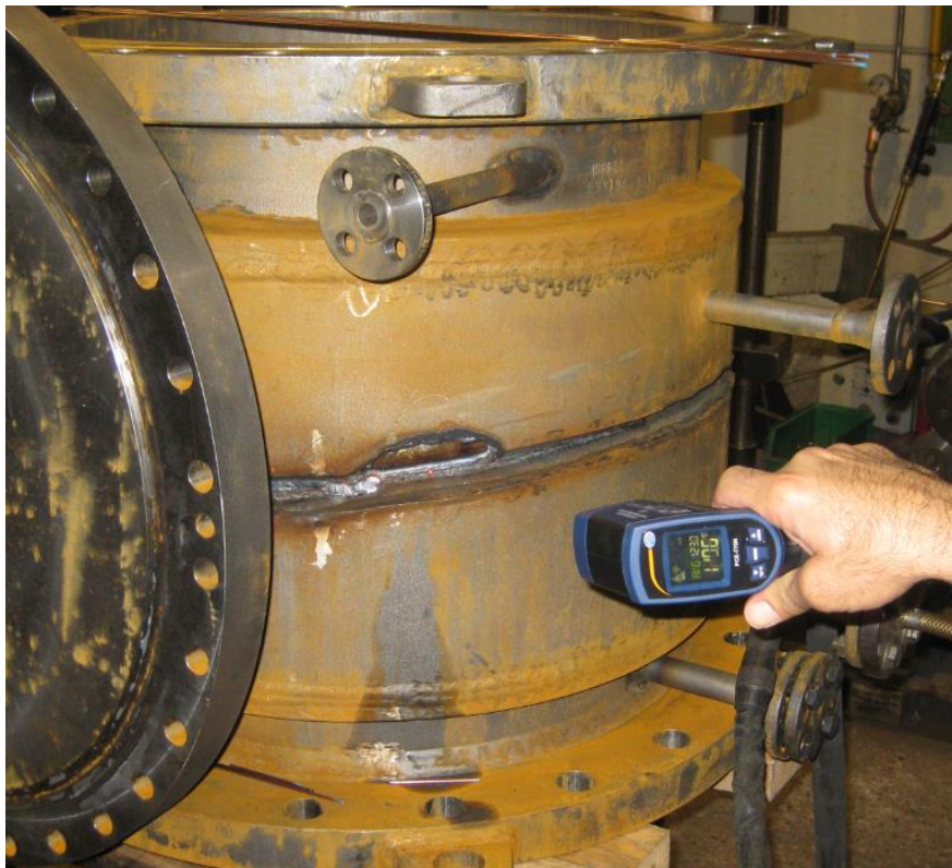
Überprüfung der Temperatur der Schweißnaht während bei Reparatur
