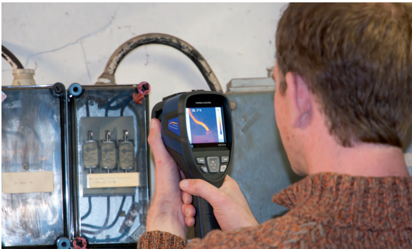
Kontrolle am Stromverteiler
