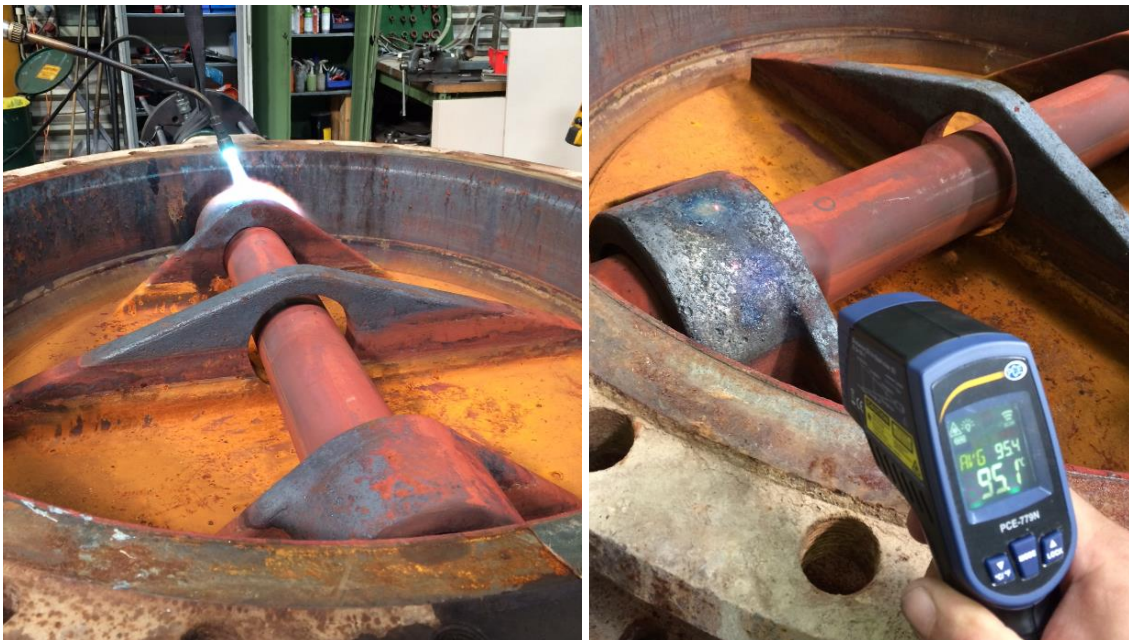
Erwärmung von den Disk-Naben und Kontrolle der Temperatur am Schaft vor dem Herausdrücken.
