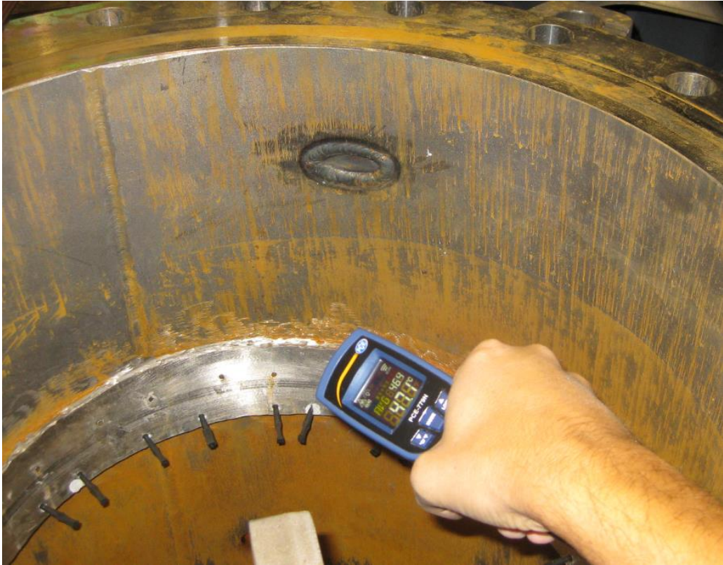
Überprüfen der Temperatur innerhalb des Ventilkörpers am Gehäusesitz
