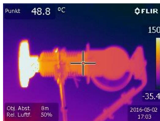
Abb. 29. Wärmebildaufnahme am laufenden Motor
