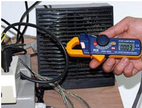
Mini ampèretang PCE-DC 3 bij het bepalen van de spanning van een elektrische kabel.
