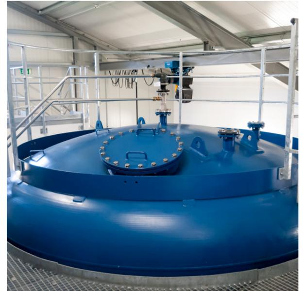
**Füllstandsanzeige mit 4 ... 20 mA Ausgangssignal / Zwei-Leiter Anschlusstechnik/
